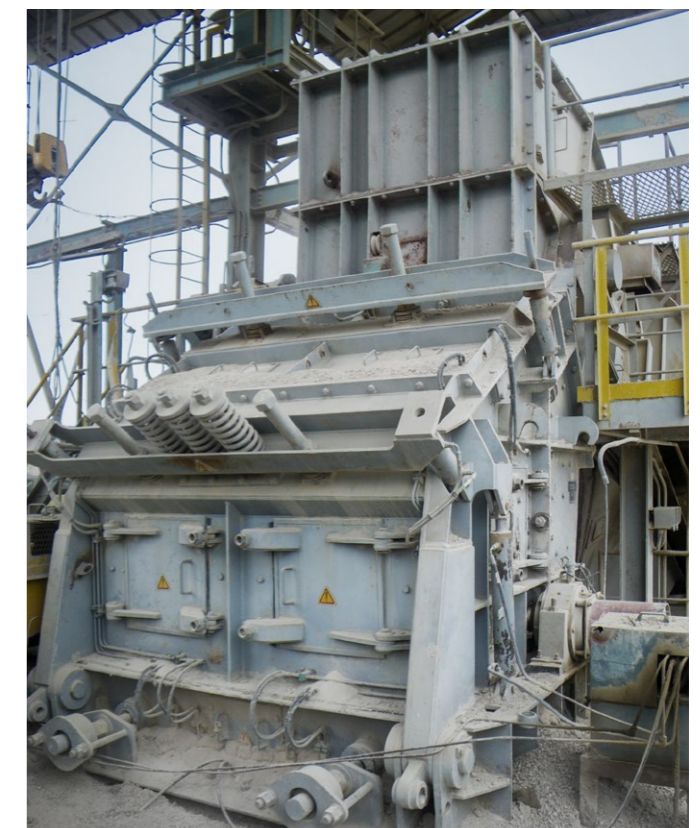
Concasseurs de calcaire dans une cimenterie
